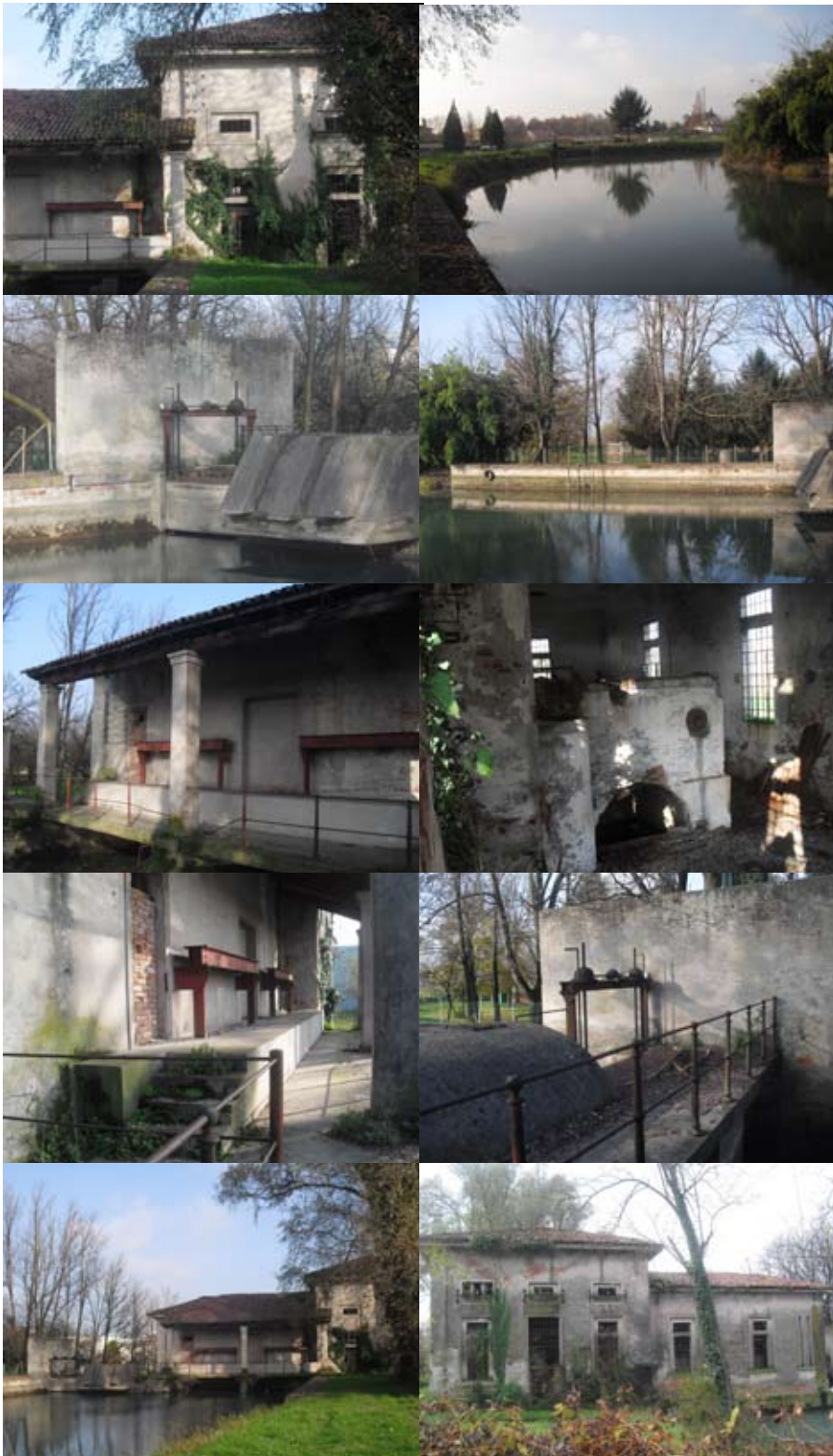
Selezione del rilievo fotografico dedicato alla Centrale Idroelettrica sulla Roggia Contarina.
